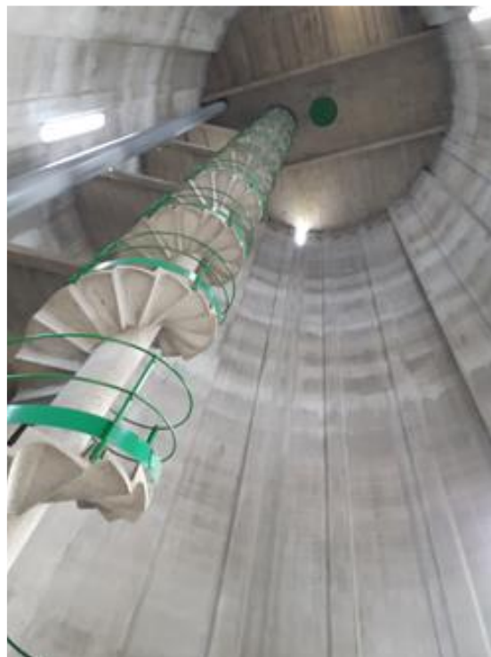
Intérieur du château d'eau de Périgné 23 septembre 2022
